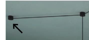
**Baldachin „B“** zur dezentralen Einspeisung
