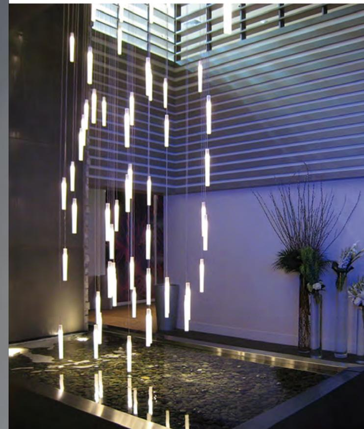
Diese LED-Pendelleuchte mit satiniertem Acrylglaszylinder ist im Durchmesser 30 und 50 mm erhältlich. Sie kann auf Wunsch auch projektspezifisch in anderen Lichtfarben, Längen und Leistungsstärken gefertigt werden. Für die Gruppenmontage können Deckenbaldachine nach Maß produziert werden.
